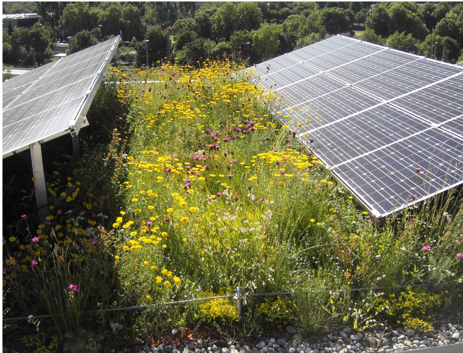
Foto: Beispiel einer extensiven Begrünung mit heimischen Pflanzen auf einem Dach mit Solaranlage, Quelle: Rieger-Hofmann
