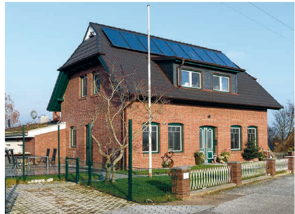
Das alte Haus erstrahlt mit neuer Fassade und moderner Solarthermie-Anlage im neuen Glanz.
